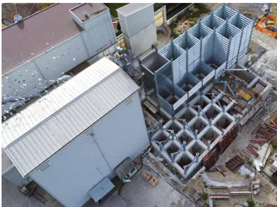
*Impianto in costruzione per stoccaggio completo del mulino: materia prima, prodotti finiti e sottoprodotti. Iniziativa realizzazione celle grecate per grano.*
